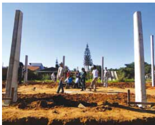
Voluntários no início da construção do templo (5ª Região).
